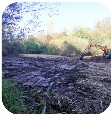
A gauche : Etrépage du sol (retrait de la couche superficielle) ; A droite : Mise en eau du site et repousse de la végétation deux mois après travaux
