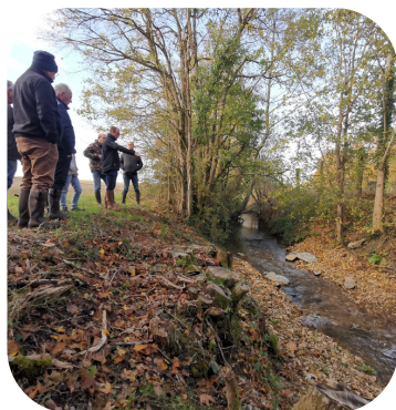
Présentation aux élus du SYAGC des travaux de recharge granulométrique sur la Luire
