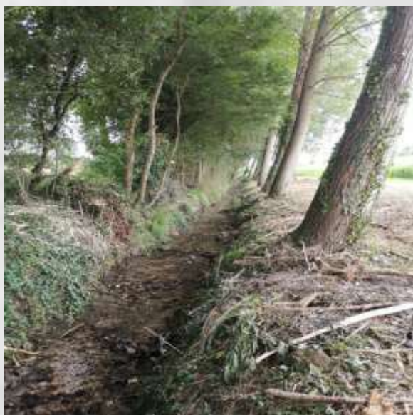
Gué de la Reine — avant travaux
