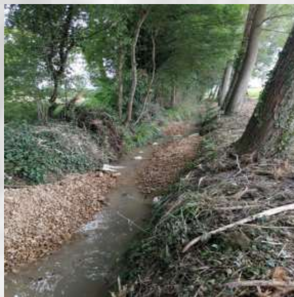
Gué de la Reine — après travaux
